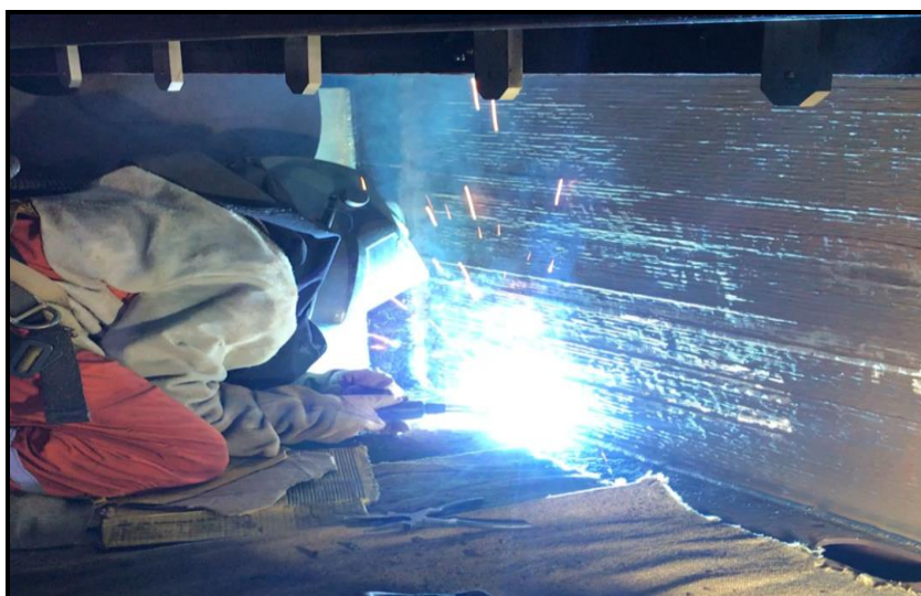
Figura 9 – Soldagem manual
