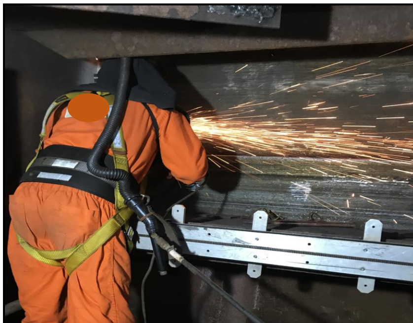
Figura 7 –Preparação de superfície por esmerilhamento
